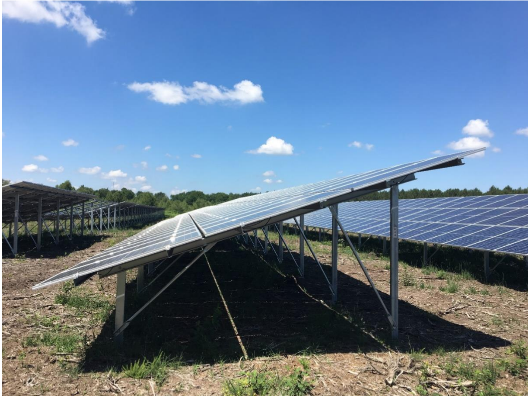
Figur 5. Exempel på fasta solpaneler, monterade på strukturer riktade mot söder.
