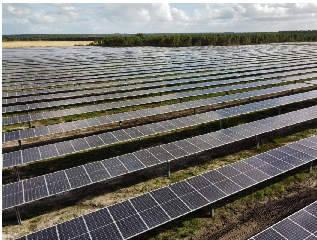
Figur 4. Exempel på rörliga solpaneler i form av enaxlade solspårare.
